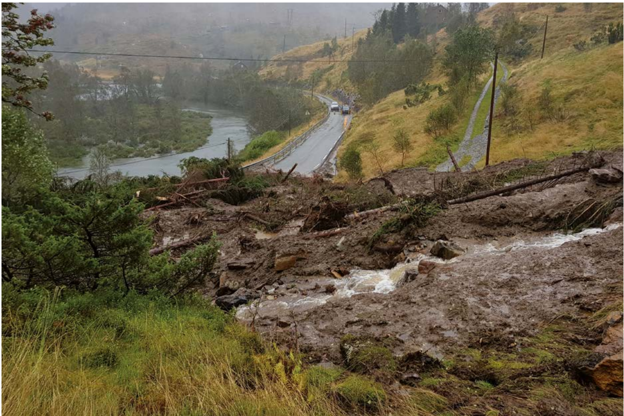
Flomskred i Vaksdal i Hordaland 2019. Foto: Statens Vegvesen.
